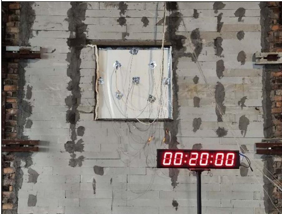
Cara no expuesta de la muestra (después de una duración de prueba de 20 minutos)
